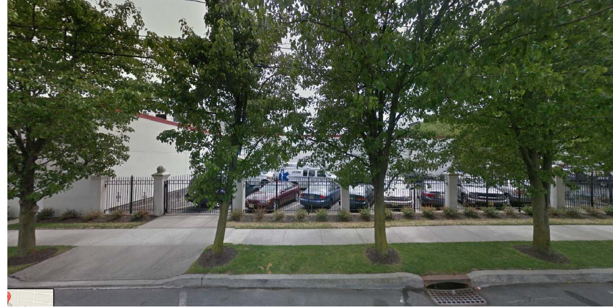
2 8TH STREET EXISTING FACADE SCALE: N.T.S.
